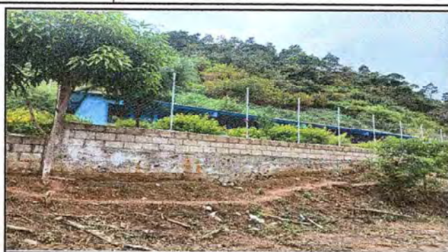
Foto 2: CULMINACION DE SUSTITUCION DE MURO PERIMETRAL
