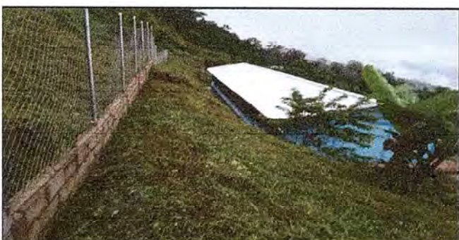
Foto 5: CULMINACION DE SUSTITUCION DE MURO PERIMETRAL
