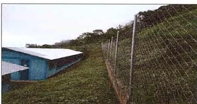
Foto 6: CULMINACION DE SUSTITUCION DE MURO PERIMETRAL
