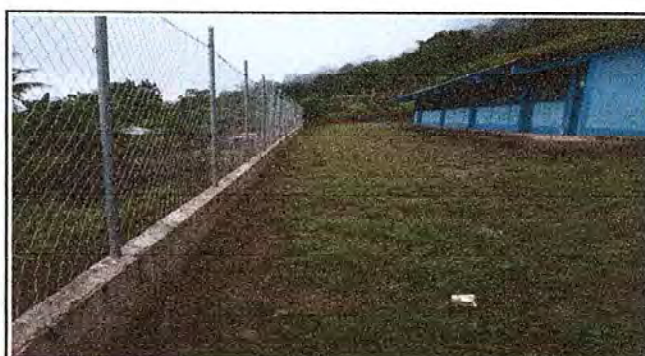
Foto 4: CULMINACION DE SUSTITUCION DE MURO PERIMETRAL
