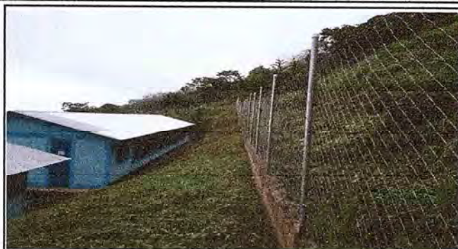
Foto 1: CULMINACION DE SUSTITUCION DE MURO PERIMETRAL
