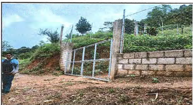
Foto 3: CULMINACION DE SUSTITUCION DE PORTON
